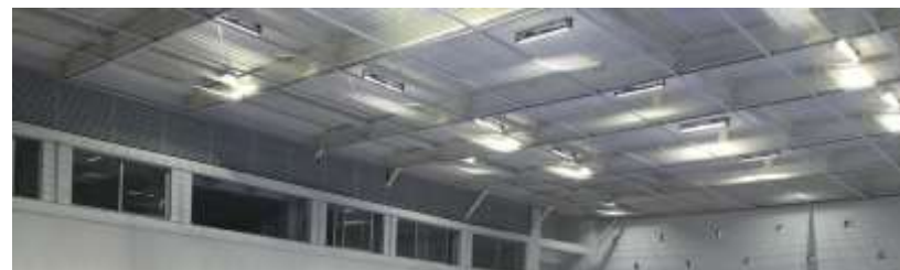
Ilustración 26. Detalle de luminaria LED para salas polivalentes y pabellones
